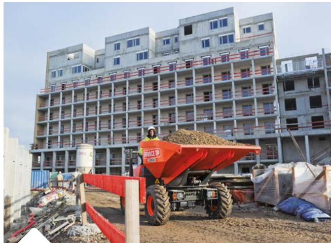
Route du Rhin, les travaux avancent à bon rythme.
