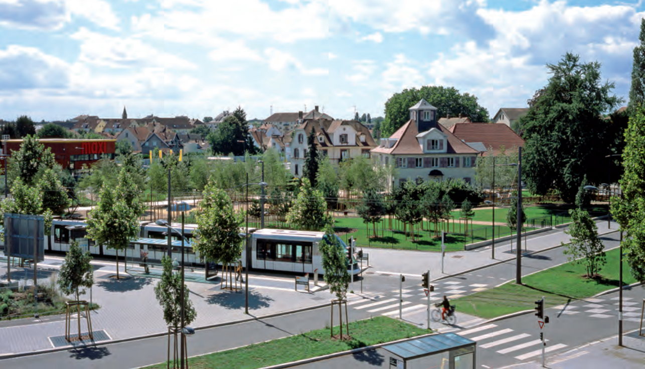
Le carrefour Reuss, Strasbourg-Neuhof. The Reuss crossroads, Strasbourg-Neuhof
