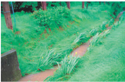
Pose dans le lit de la rivière de boudins d'hélophytes en bas de berges raides, (Muhlbaechel à Vendenheim)
