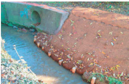
La pose de toile de jute ou de coco sur la berge avant ensemencement (Muhlbaechel à Vendenheim)
