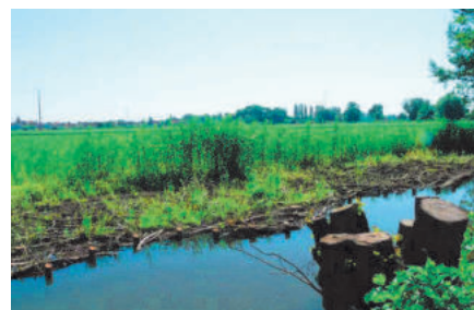
Création de banquettes par la technique de peignes en pieux et branchages. (Muhlbach d'Oberschæffolsheim).
