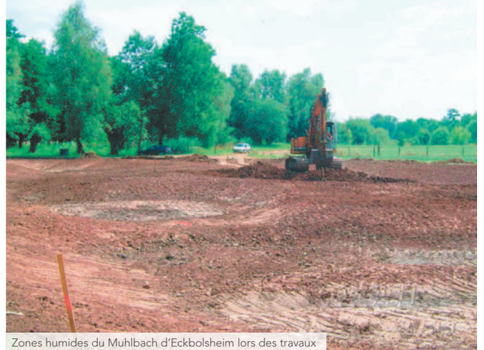
Zones humides du Muhlbach d'Eckbolsheim lors des travaux
