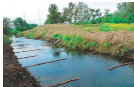
Pose d'épis en pieux pour former à terme de nouvelles banquettes naturelles (Ostwaldergraben à Lingolsheim)
