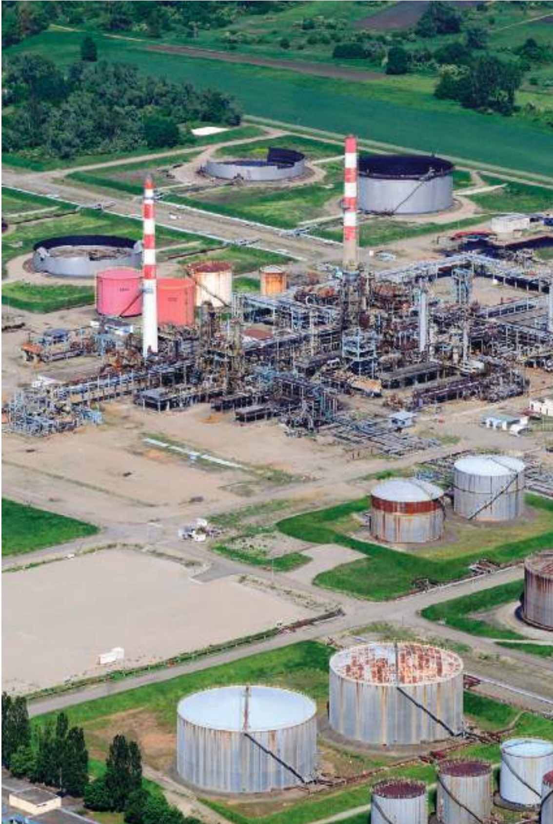
FIN D'ACTIVITÉ ET DÉMONTAGE DE LA RAFFINERIE DE REICHSTETT
