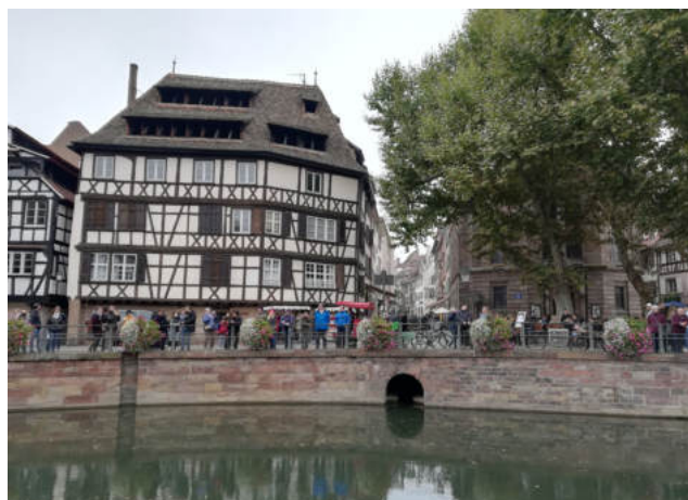
Débouché du Fossé des Tanneurs dans l'Ill, Place Benjamin Zix © ADEUS
