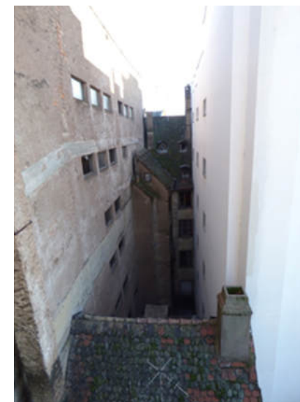
Surdensification de l'îlot : enlèvement d'une parcelle médiévale et de son bâti © B.FEDEL – AUP Lorraine
