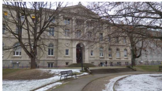
Ancien institut de chimie rue de Goethe. © B.FEDEL – AUP Lorraine
