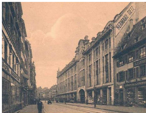
Le même bâtiment en 1913 avec le traitement homogène des baies du RDC constituant le soubassement de la composition architecturale de la façade. ©Archi-Wiki
