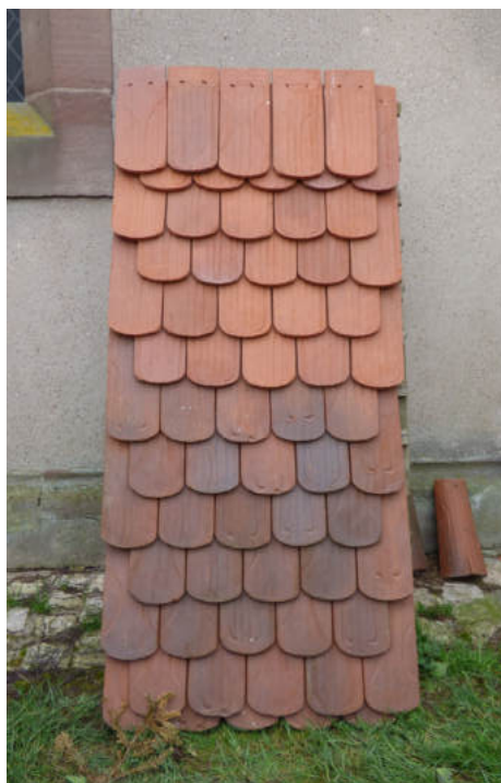
Echantillon de couverture en tuiles écaillés artisanales ©Atelier G. André
