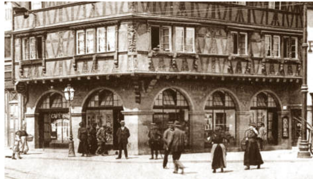
Baies d'échoppe au RDC d'un immeuble en pan de bois du XVIII e siècle, réaménagées au XIX e siècle ©AVES
