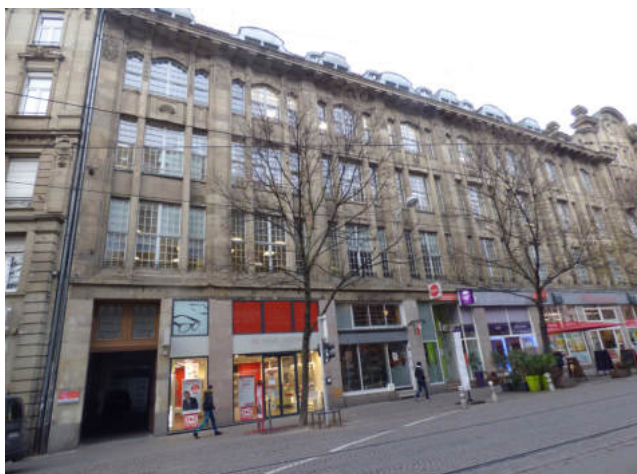
Succession de devantures différentes sur un rez-de-chaussée d'un bâtiment datant de 1909 privant le bâtiment remarquable de son soubassement. ©Atelier G. André
