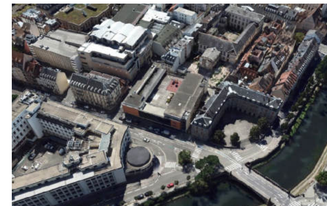
Même îlot aujourd'hui, l'hôtel particulier a été détruit par les bombardements de 1870 puis reconstruit pour devenir un tribunal. Le jardin a été construit dès les années 1840 pour y implanter la prison sur le site de l'actuel gymnase Schoepflin... Source : maquette 3D Strasbourg
