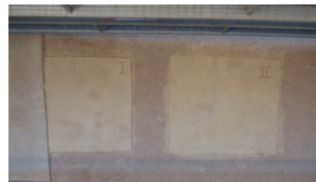
Echantillons de la couche d'enduit de finition sur les sous-couches © Atelier G. André
