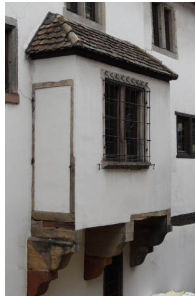
Ouvrage en surplomb début Renaissance : valeur de rareté, d'ancienneté et de génie constructif © Bailly-Leblanc
