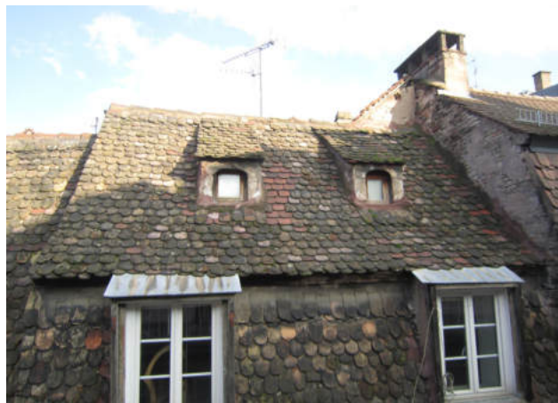
Couverture en tuiles écaillés sur une toiture brisée «à la Mansart» du XVIII e siècle, ©Bailly-Leblanc
