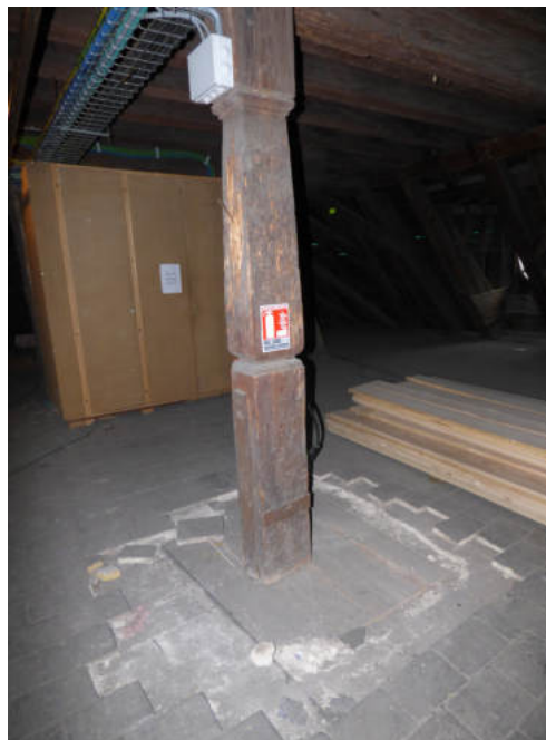
Comble à poteaux, plancher bois protégé par un dallage de terre cuite © Atelier G. André
