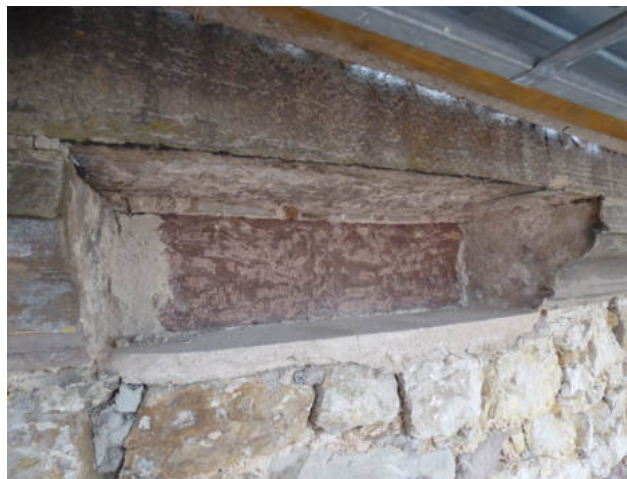
Purge d'un élément de corniche en grès avant remplacement par une pierre saine © Atelier G. André
