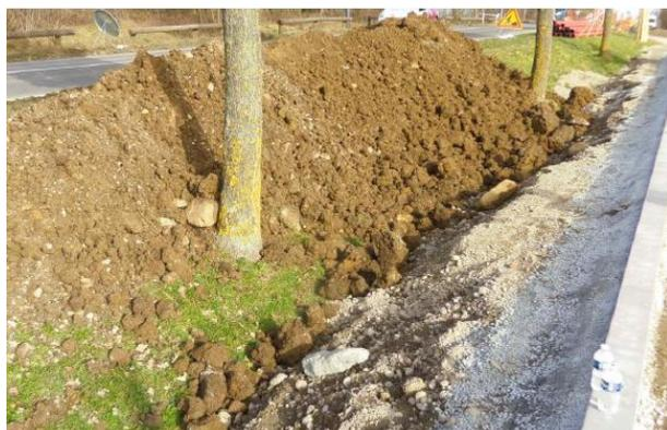
*Photo 6 : Stockage de matériaux au pied de l'arbre = asphyxie du système racinaire*
