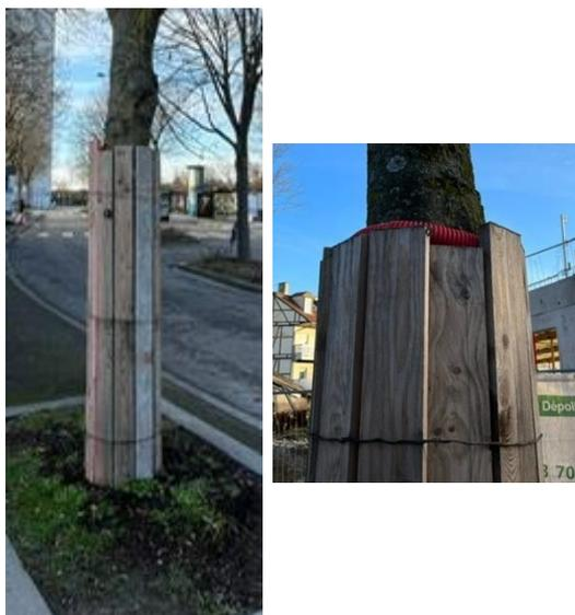
*Photo 9 : Photos d'un exemple de protection des troncs contre les chocs*
